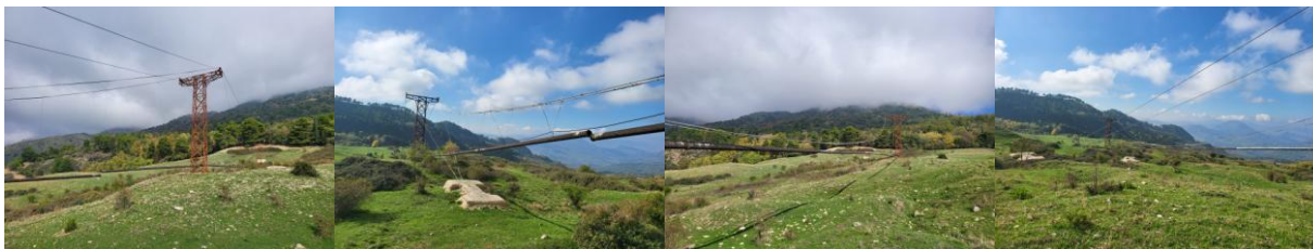
Anni Ottanta del secolo scorso. La condotta idrica aerea che avrebbe dovuto portare l'acqua dei pozzi di Sanguisughe al centro abitato di Polizzi Generosa.
