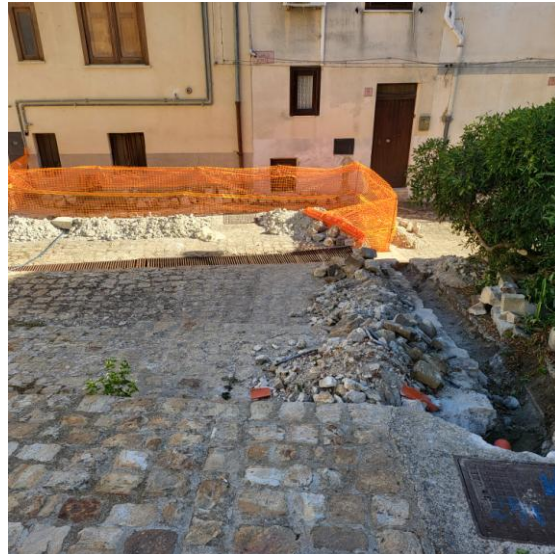
Nuova rete idrica Largo Ponte
