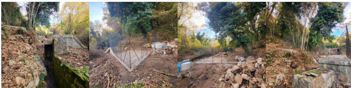
Sorgente Pietra Ardica – Lavori di messa in sicurezza
