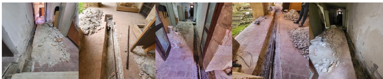
Lavori di efficientamento energetico del Palazzo della Cultura
