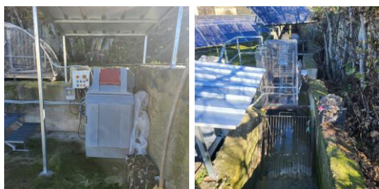
Lavori di adeguamento funzionale e tecnologico dell'impianto di depurazione di contrada Junci
