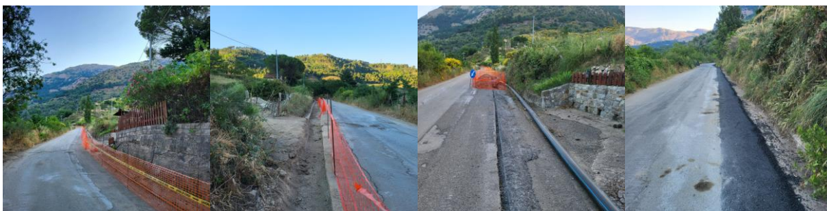
La nuova rete idrica esterna. 550 mt lungo la SP 119
