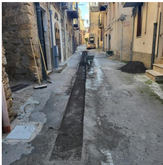
Nuova rete idrica Via Notar Nicchi
